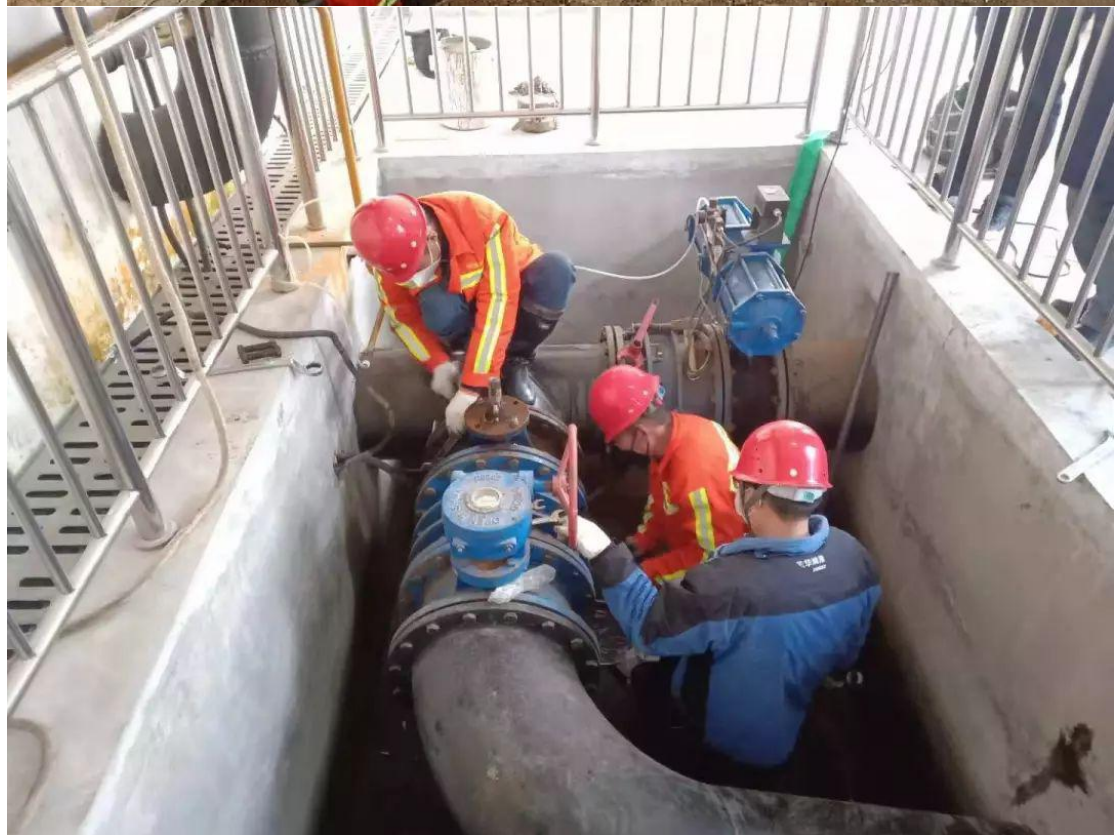
（图为自来水公司在检修供水设施）
