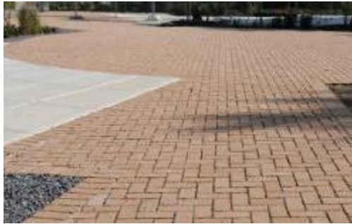
图 E.1-1 透水铺装
