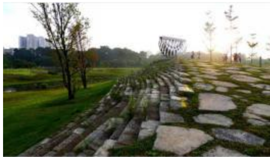
图 C. 4. 1-4 回用混凝土被用于驳岸建造
