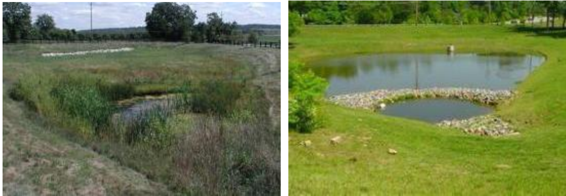
图 E. 5-1、图 E. 5-2 渗透塘
